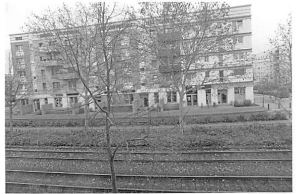
写真9 外断熱改修の行われた集合住宅
