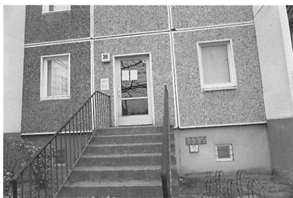
写真12 写真11と同じ集合住宅。降雪もある事から1階の入り口が地盤より高い場所に設けられている。
