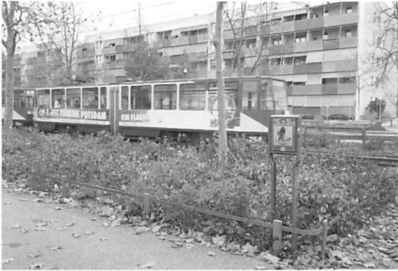
写真6 外断熱改修の行われた集合住宅
