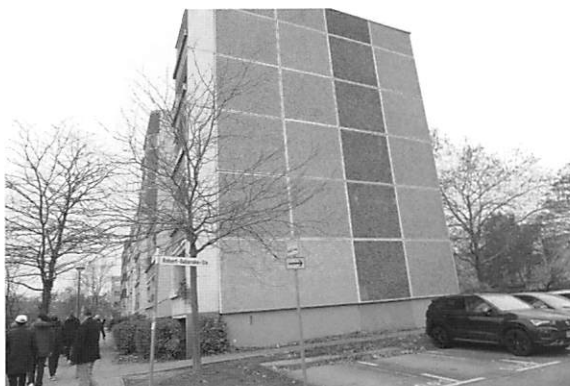
写真11 旧東独ではどの都市に行ってもプレキャストコンクリート集合住宅(プラッテンbau: Plattenbau)が見られた。コンクリートにアスベストが含まれていたことからそれらの集合住宅は取り壊されたが、ここには残っていた。しかし旧東独時代の面影はなく、コンクリートには化粧が施されていた。
