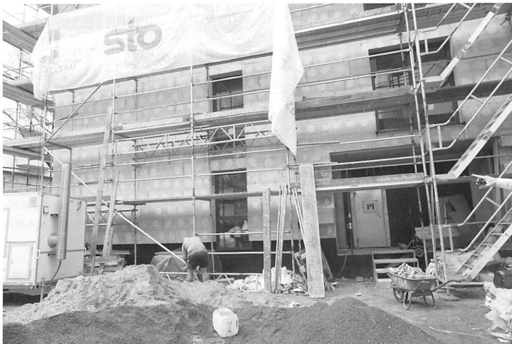
写真1 ベルリンの外断熱施工現場
