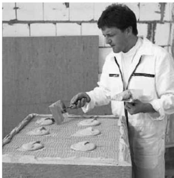
図8 EPS断熱材の外壁への取り付け
