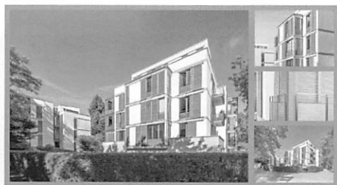
写真7 住宅断熱改修部門優勝作品
