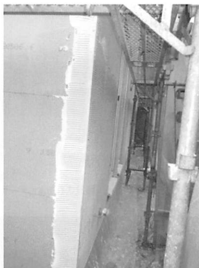
写真4 厚さ10cmの木毛繊維断熱材を使用した外断熱住宅の工事
